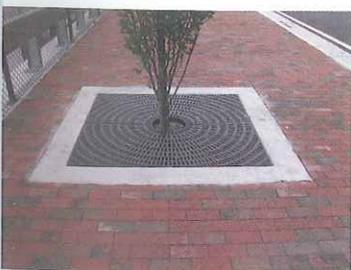
Plantco présente City Grate, une nouvelle grille d'entourage d'arbres, fabriquée en polyéthylène haute densité (recyclé et recyclable). Proposée en format rond, carré ou mixte (en deux parties) de 122 ou 152 cm de largeur, elle se déplace manuellement sans problème particulier et peut être facilement
